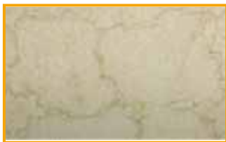
Fleckenmuster durch Verunreinigungen im Dampfcondensat
